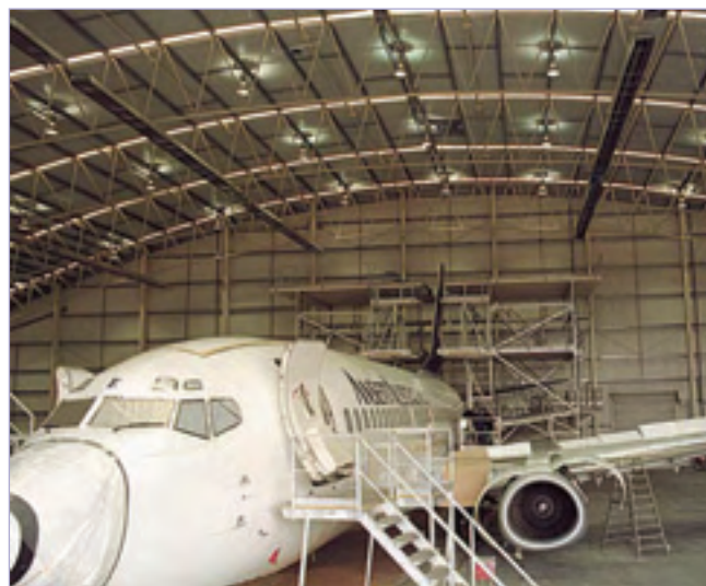
Instalacja w hangarach lotniczych, Australia.
